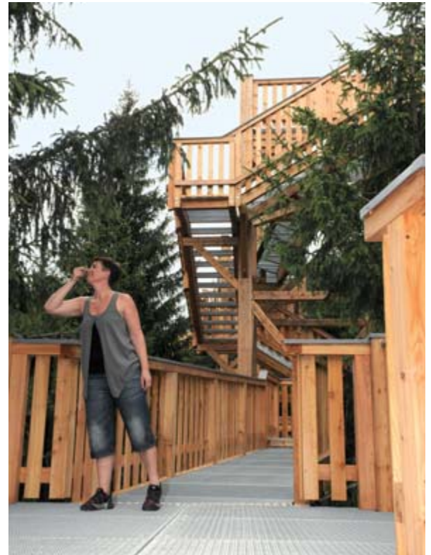
Der Baumzipfelweg besteht aus massivem Lärchenholz und ist über Treppen, Türme und Brücken über mehrere Stockwerke bis 30 m über dem Boden zwischen Baumwipfeln angelegt. Foto: TVB Saalbach
